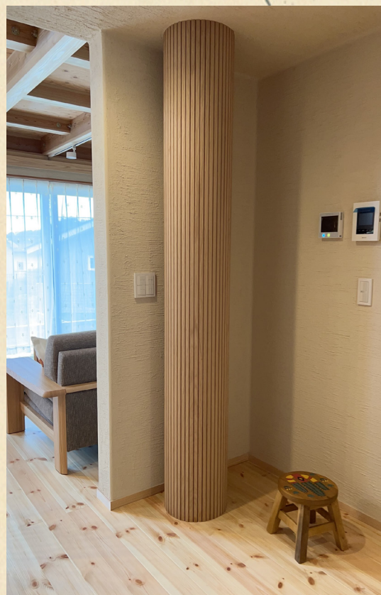
OM ダクト写真
